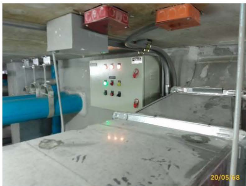
ระบบกรองอากาศพื้นที่จอดรถ
