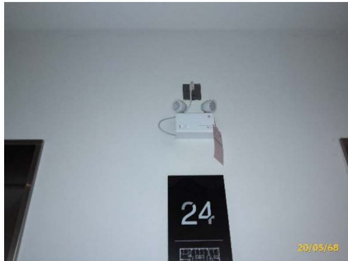
ไฟฟ้าส่องสว่างฉุกเฉิน
