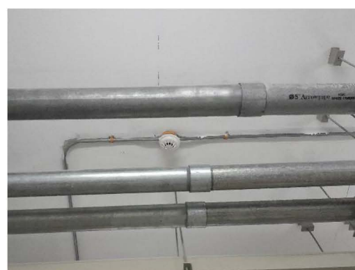
เครื่องตรวจจับควัน (ห้องหม้อแปลงไฟฟ้า)
