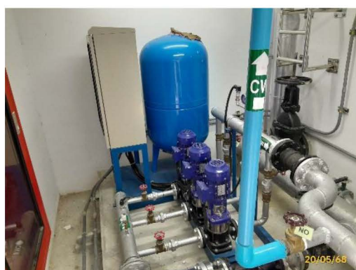
Booster Pump อาคาร X
