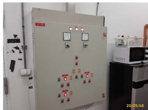
แผงควบคุมบ่อน้ำ
