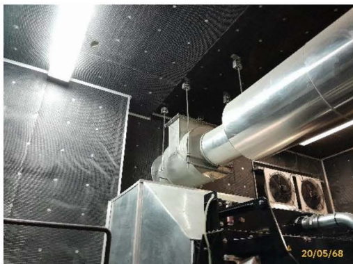
ระบบกรอง Scrubber Filter
